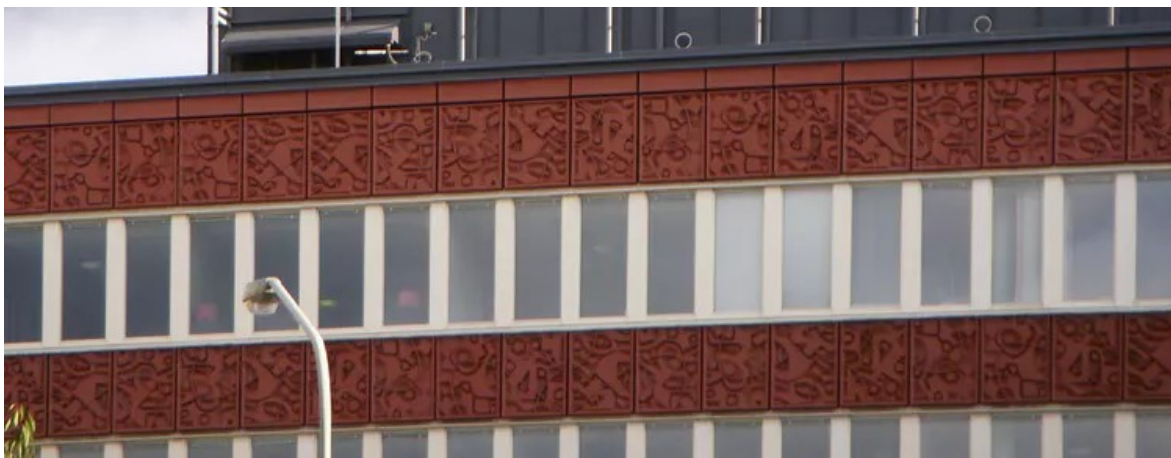
Tagging contractor. Wikimedia
