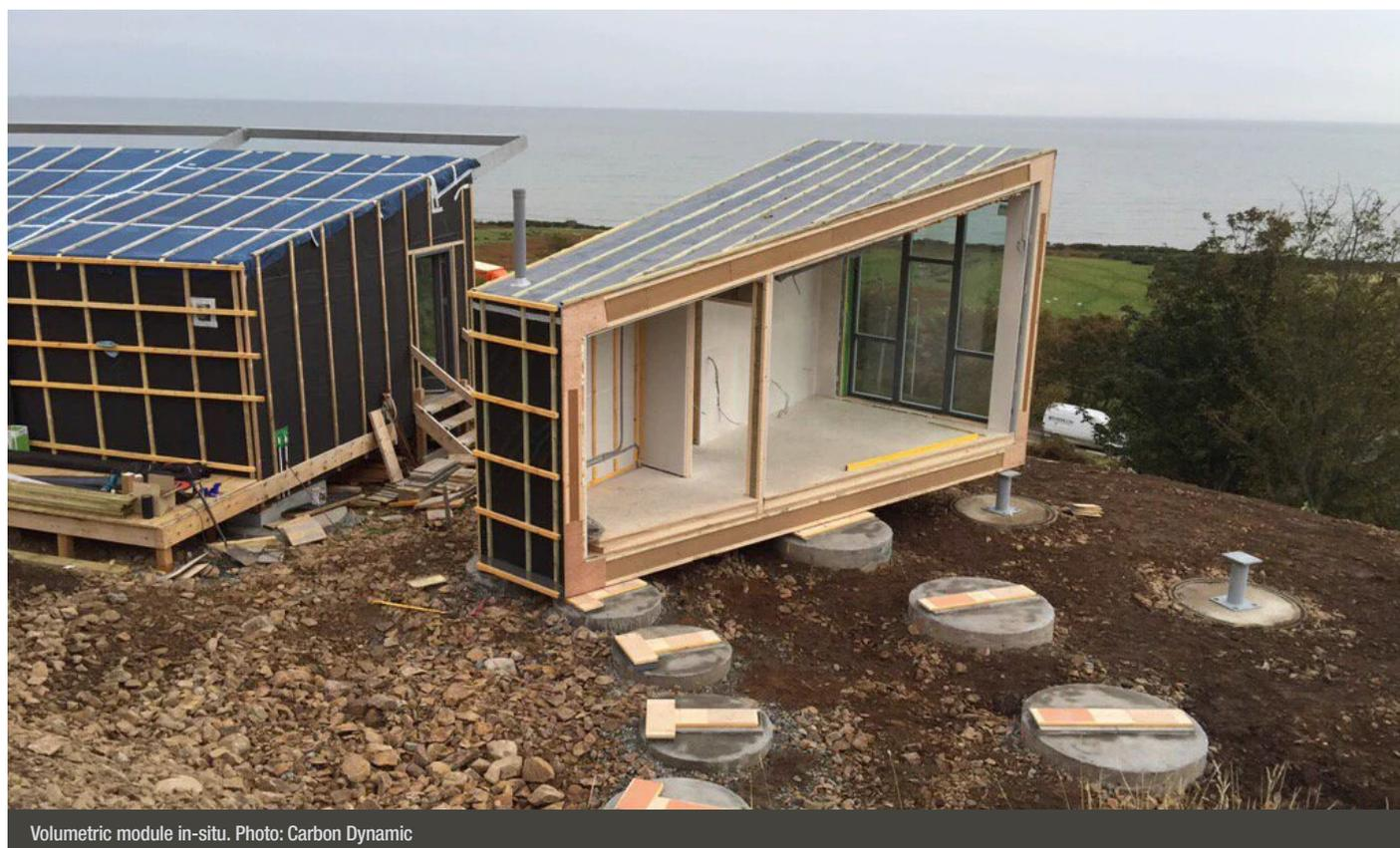
Volumetric module in-situ. Photo: Carbon Dynamic
